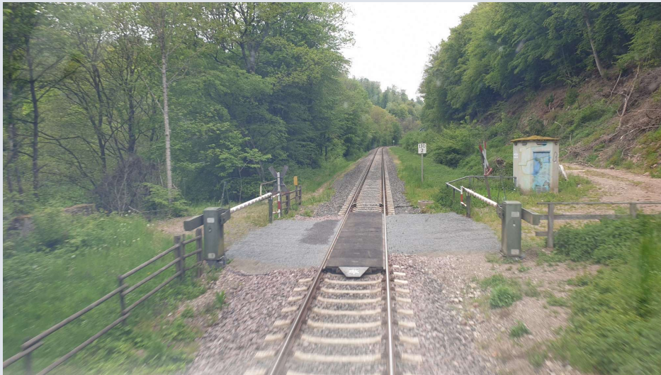
Beschränkter Bahnübergang in km 130,2 kurz vor Bitburg
